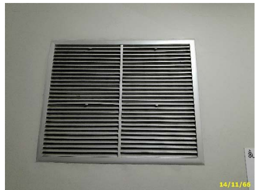
ระบบอัดอากาศอากาศ
